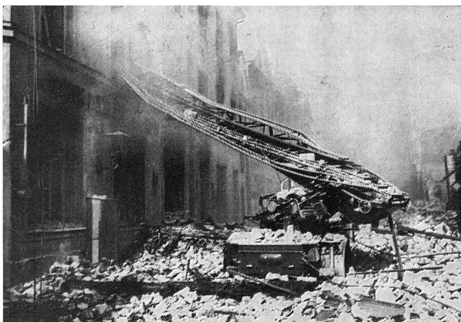
Bild 3 Durch Maueresturz beschädigte Feuerwehrliefer.
