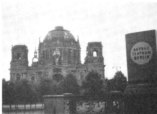
Der beschädigte Berliner Dom
