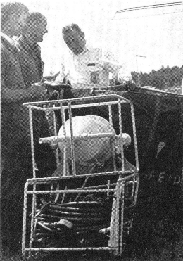
Mit Fallschirm wird im Katastrophengebiet ein kleineres Wasseraufbereitungsgerät abgeworfen, während gleichzeitig die Bedienungsmannschaft mit Fallschirmen abspringt, den Apparat zum Einsatzort abschleppt, wofür sich am Transportbehälter Kufen befinden.
