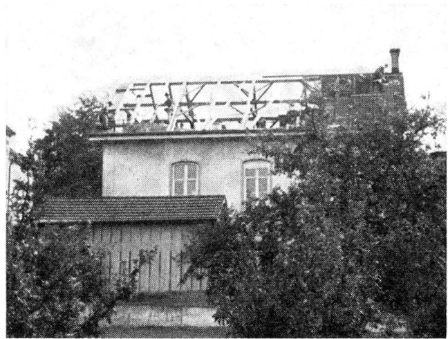
Hier wurde der gesamte Dachstuhl erneuert
