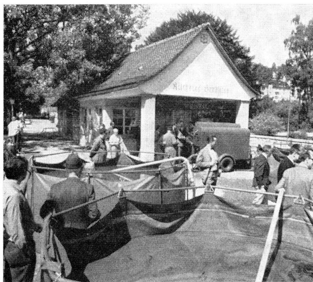
Wasseraufbereitung in Kilchberg/Rüschlikon ZH. Vom Zürichsee wird kontaminiertes Wasser in die Vorbehandlungsbehälter (15 m 3 Fassungsvermögen) und von dort in die mobile Wasseraufbereitungsanlage gepumpt
