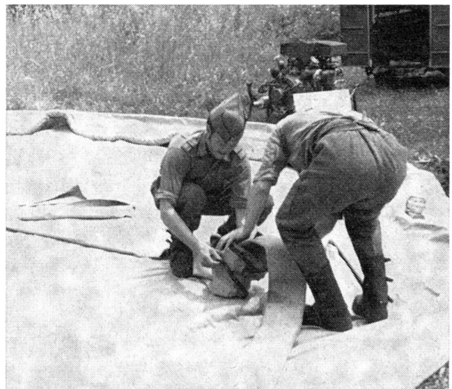
Abb. 8b. Anschluss des Transportschlauches, Durchmesser 110 mm, zum Füllen des Beckens
