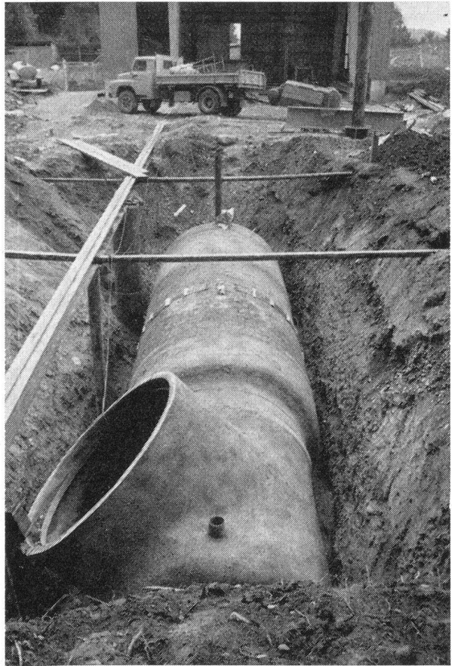
Abb. 21. Fertig verschweisstes und ausgefügtes Bauwerk in der Grube vor dem Eindecken
