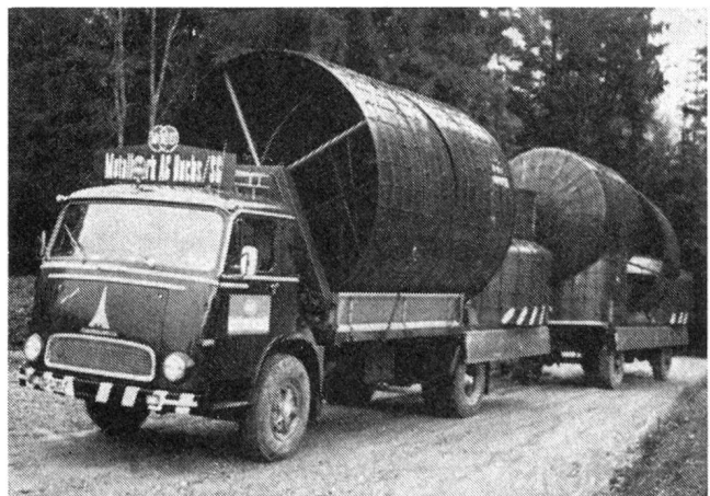
Abb. 17. Transport der Blechzylinder für die Elemente eines 6 m langen Schutzraumes mit einem 7 m langen Vorräum und Abzweiger
