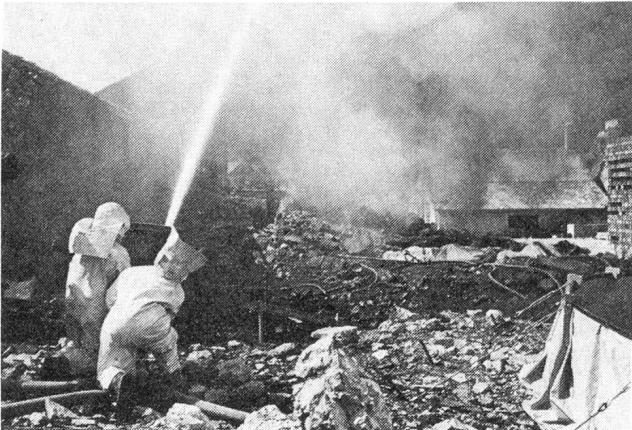
Im Mat Kurs 70 wurden zwei Modelle von Wasserkanonen ausprobiert, um mit weniger Leuten mit mehr Druck viel Wasser auf möglichst grosse Entfernung zu bringen
