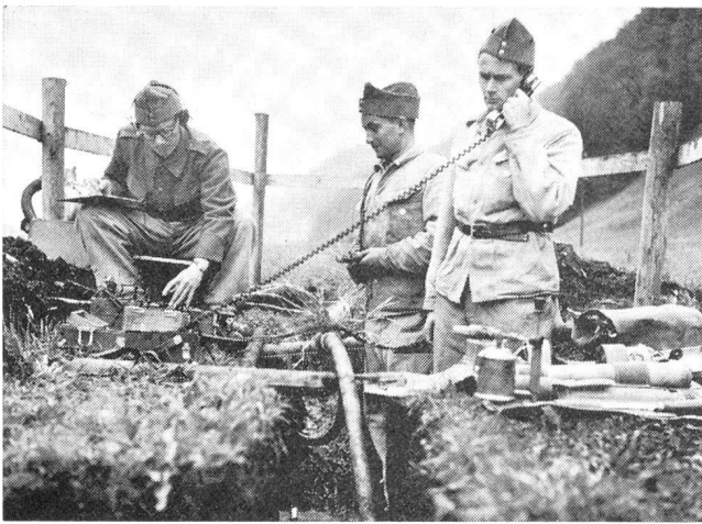
TT-Betriebsgruppe bei der Reparatur eines Kabels
