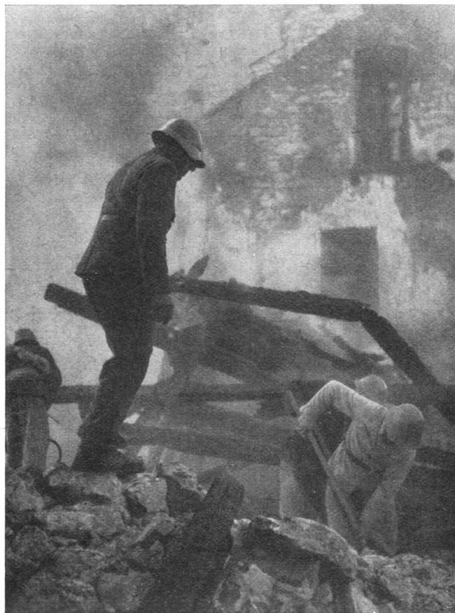
Befreiung von Verschütteten
