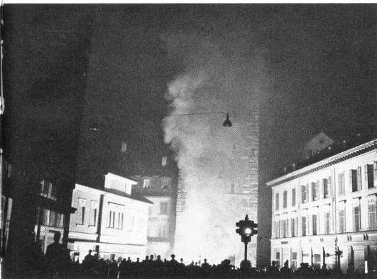
Stadtzentrum und Schlossbergplatz liegen im schwerbetroffenen Katastrophengebiet
