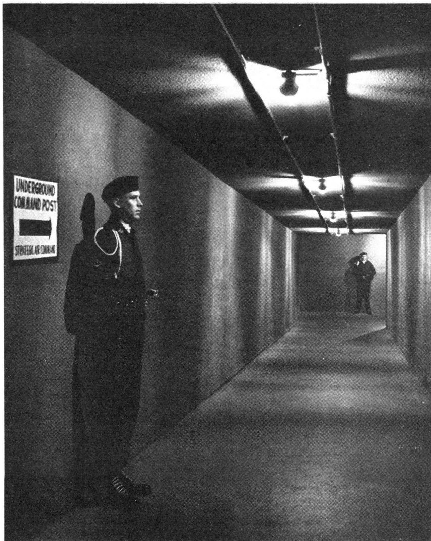
Sicherheit vor Sabotage und Luftangriffen — Der gutbewachte Eingang in die unterirdischen Anlagen der Einsatzzentrale des amerikanischen strategischen Luftwaffe-Hauptquartiers.
