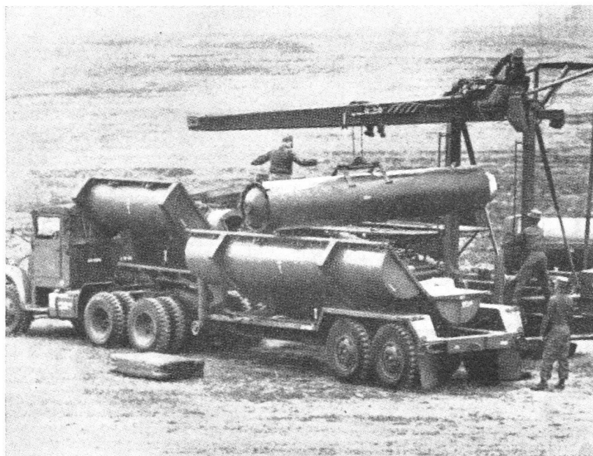
Bei der Montage der «Sergeant»-Rakete. Man beachte die zylindrischen Behälter, in denen die Bauteile der Rakete eingeschlossen sind.
