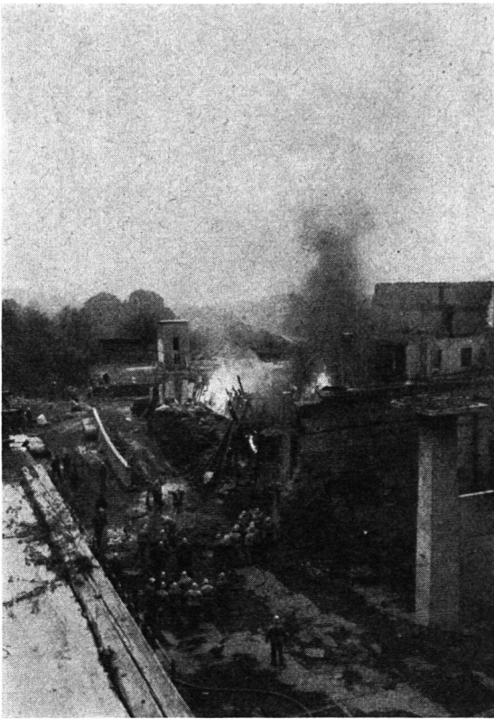
Der Uebungsbrand ist gelegt. Die Einsatzzüge erhalten die letzten Weisungen, um sich dann von zwei Seiten an das Objekt heranzuarbeiten, aus dem es Menschen zu retten gilt, die in einem Schutzraum verschüttet wurden.
