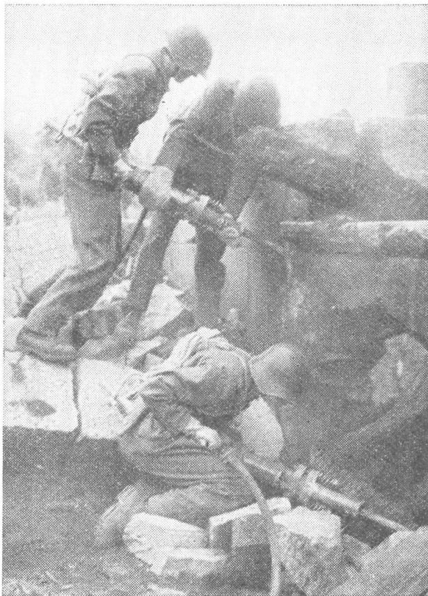
Luftschutztruppen im Einsatz.
