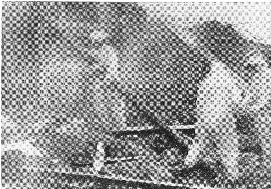
Vom Einsturz bedrohte Mauern werden abgestützt, um die Rettungsarbeiten nicht zu gefährden.
