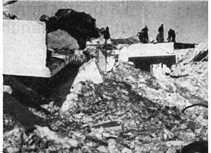
Etage supérieur dégagé, deux morts; sous-sol, y compris abri, intact
