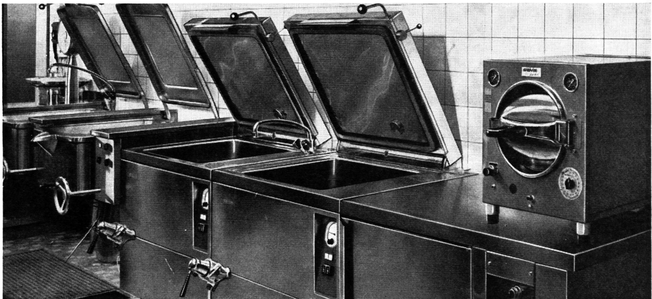
Teilansicht Kantine Geigy - Burckhardt Architekten SIA
