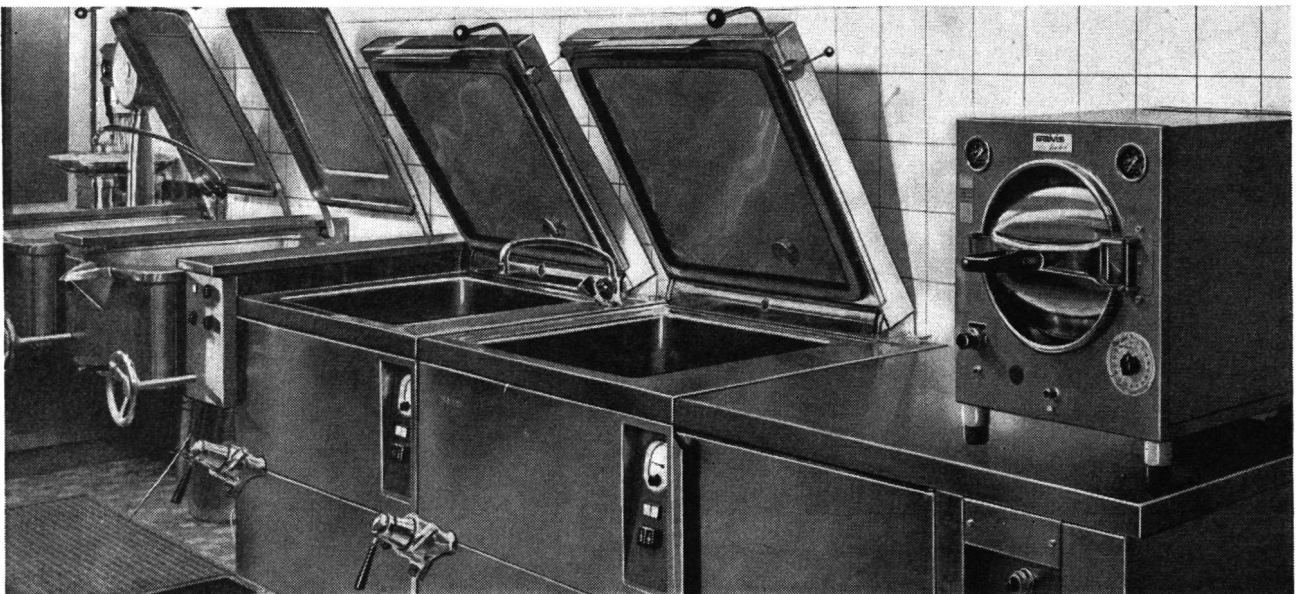
Teilansicht Kantine Geley - Burckhardt Architekten SIA
