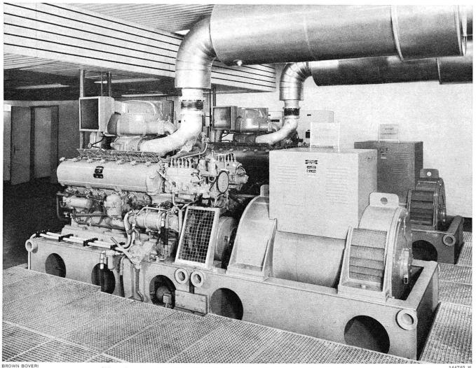
Dieselelektrische Notstromgruppen (2x730 kVA) eines PTT-Gebäudes
