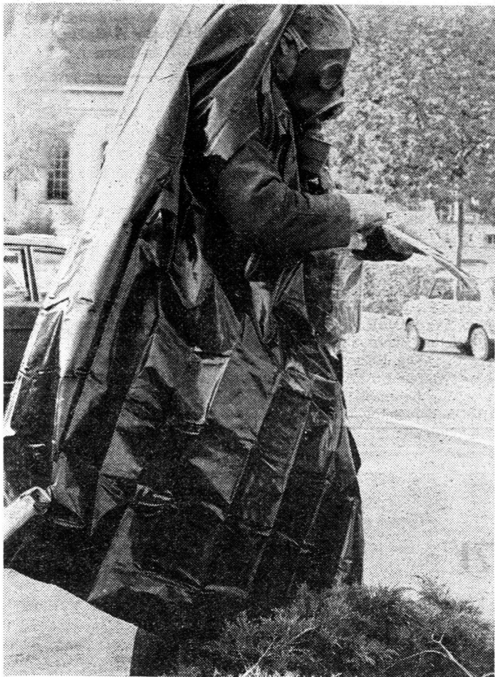
A-Spürer misst, indem er sich dreht, die Verstrahlung
