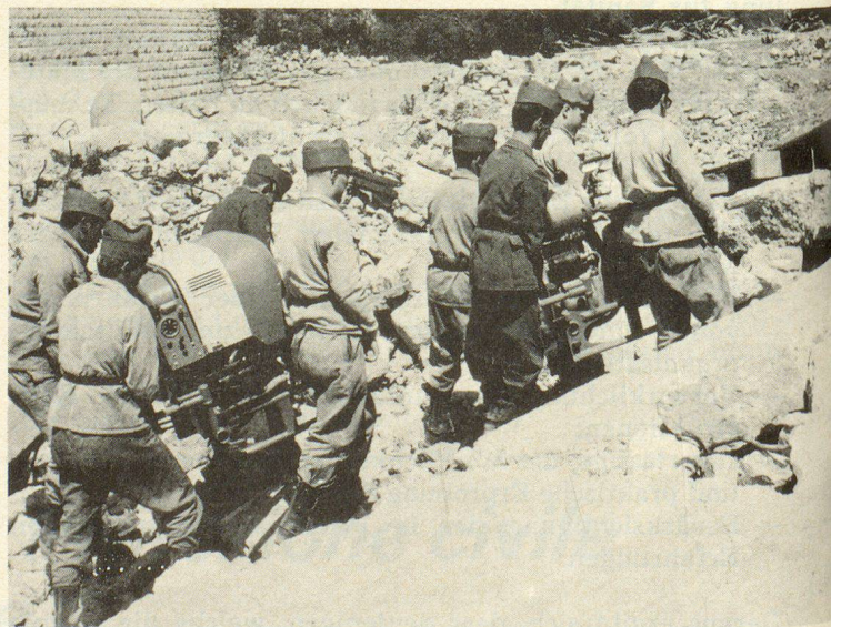
Tragversuche mit Kompressor- und Motorteil auf der Trümmerpiste
