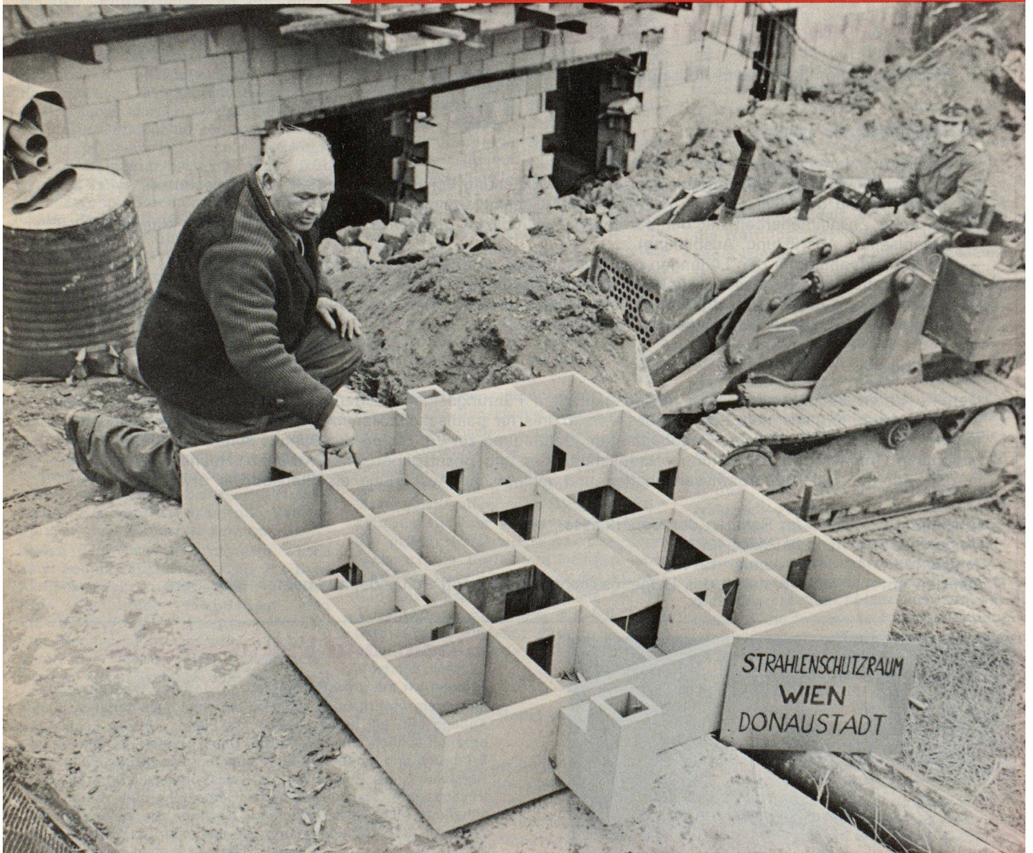
Modell des Gross-Schutzraumes, dessen Aushubarbeiten von Soldaten des österreichischen Bundesheeres übernommen wurden
