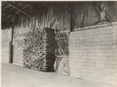
Beispiel der Verstärkung der Stallmauern, damit das Vieh besser gegen radioaktiven Ausfall geschützt ist. Ziegelsteine, Sandsäcke, Plasticfolien
