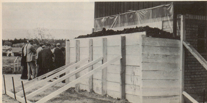
Ein weiteres Beispiel der Verstärkung des Schutzes durch einen mit Brettern eingefassten Erdwall
