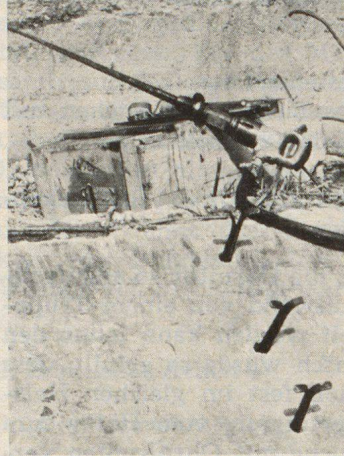
Abb. 29. Drei Bohrlöcher in armiertem Beton
