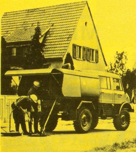
Unimog-Hochdruck-Kanalspüleinrichtung 1000-1200 m Tagesleistung.
