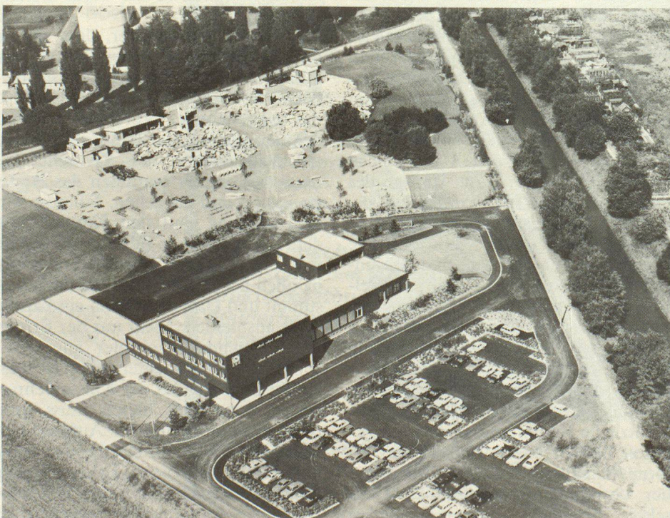
Das Zivilschutzzentrum der Stadt Zürich aus der Vogelschau. Im Vordergrund mit dem Parkplatz das Theoriegebäude, dahinter das Übungsgelände mit der Trümmerpiste und allen für die Ausbildung notwendigen Objekten.
