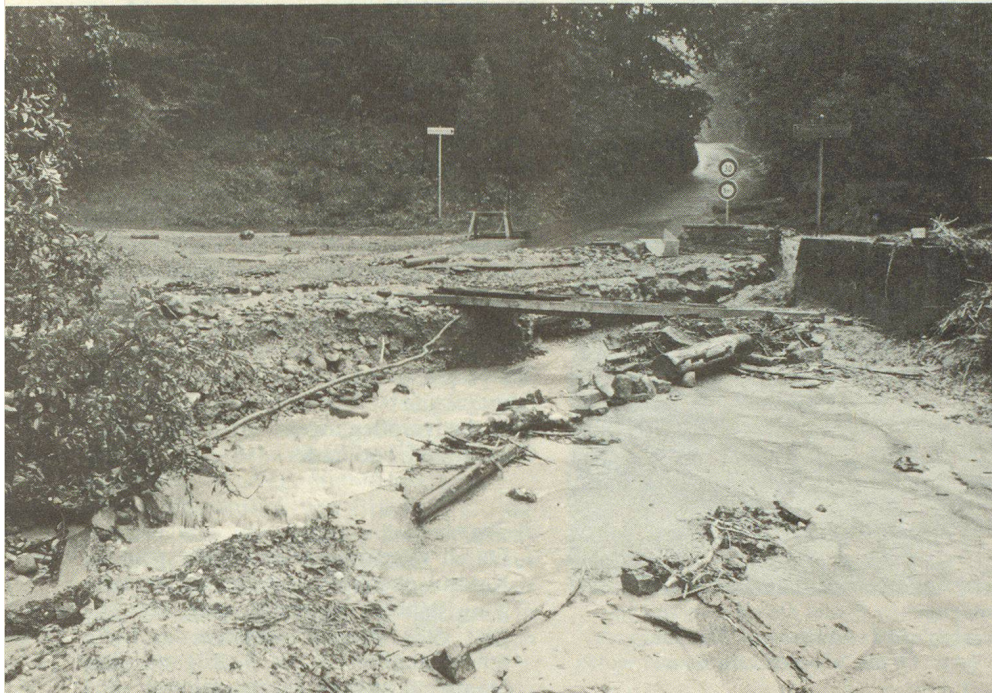
Wassermassen, die Strassen in verheerendem Zustand zurücklassend
