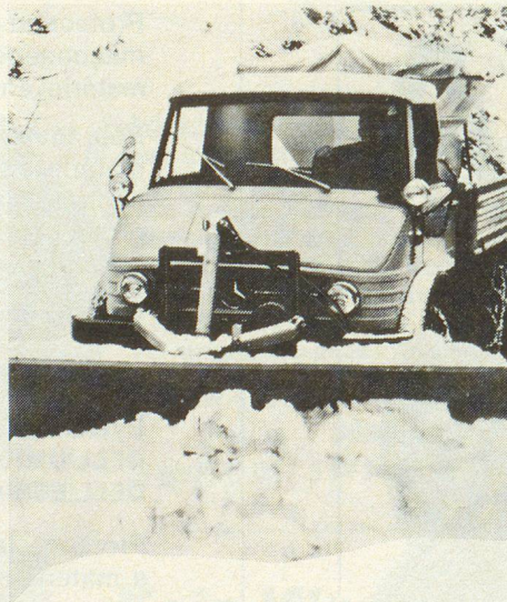
Die Unimog-Schneepflug-Streuerkombination arbeitet bei 20-30 km/h bis in den letzten Winkel.
