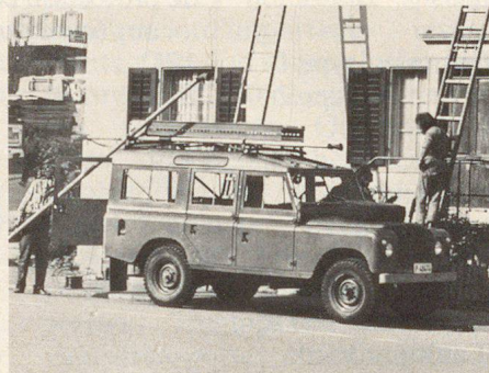
Pose de lignes téléphoniques ou câbles aériens
