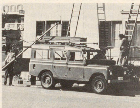
Pose de lignes téléphoniques ou câbles aériens
