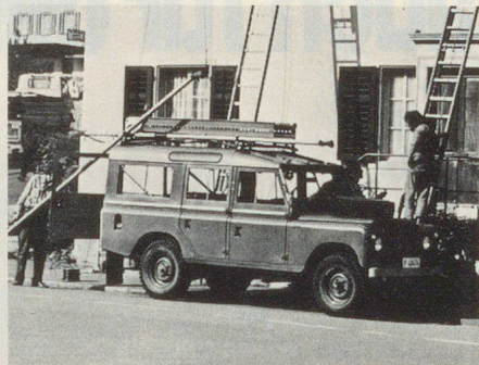
Telefonleitungs montage oder Freileitungsbau
