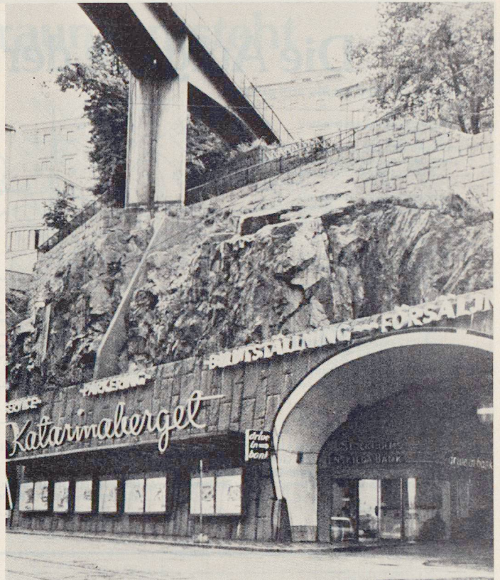
Die Schweden haben im Schutzraumbau, vor allem beim Bau von Grossschutzräumen, den Vorteil ihres harten Granits. Hier der Eingang zu einem der zahlreichen Grossschutzräume in Stockholm, Katrinaberget, der im Frieden als Garage genutzt wird.
