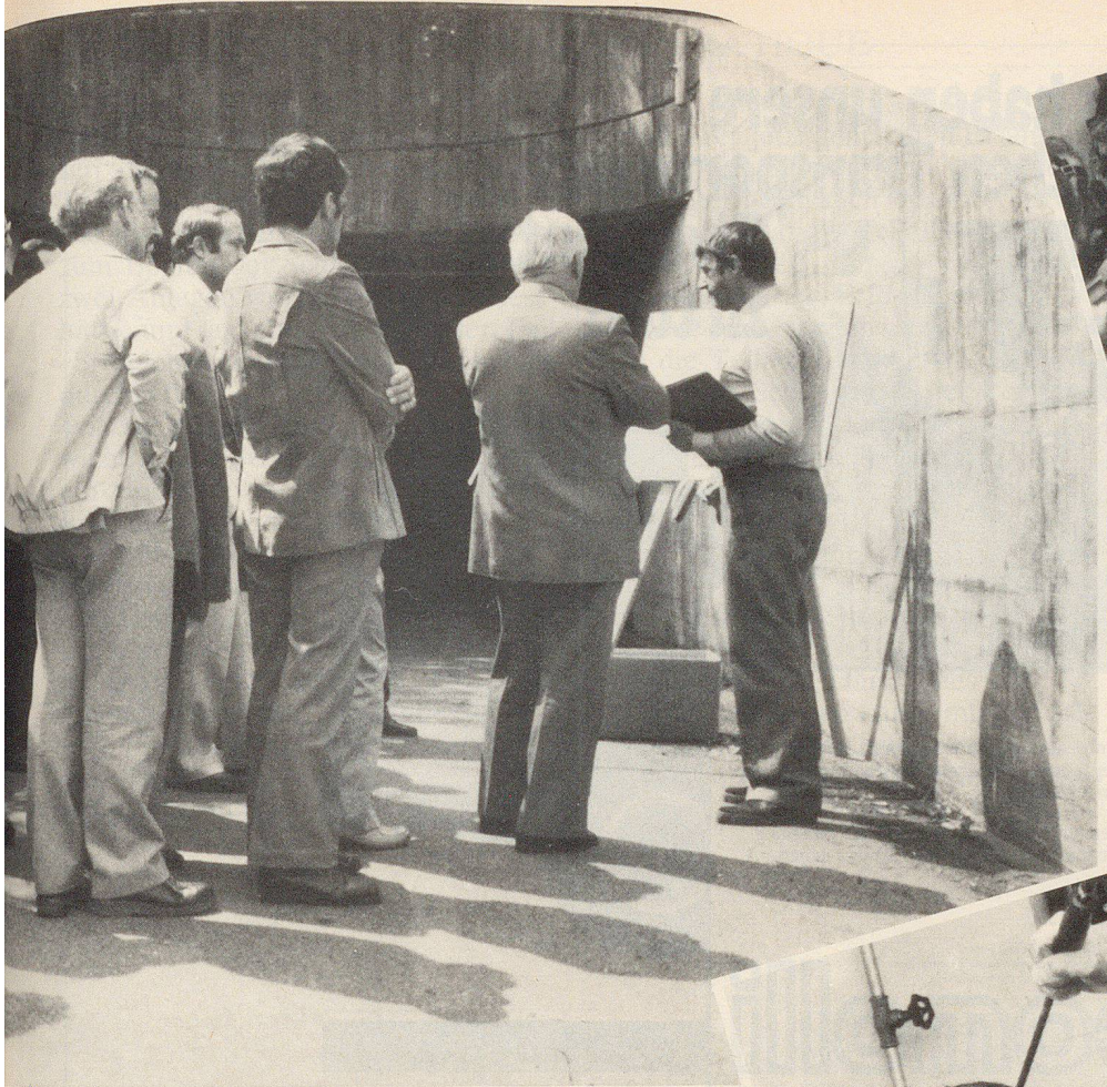
Besichtigung der Station 1 der Schleusenorganisation –vorläufig noch «trocken».
