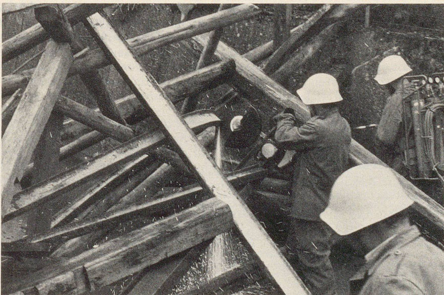
Mit Schneidbrenner und Trennscheibe wird das Hindernis angegangen – eine Übung der ZSO Muri AG. (Fotos: aus der Zeitung «Der Freischütz», Muri AG).
