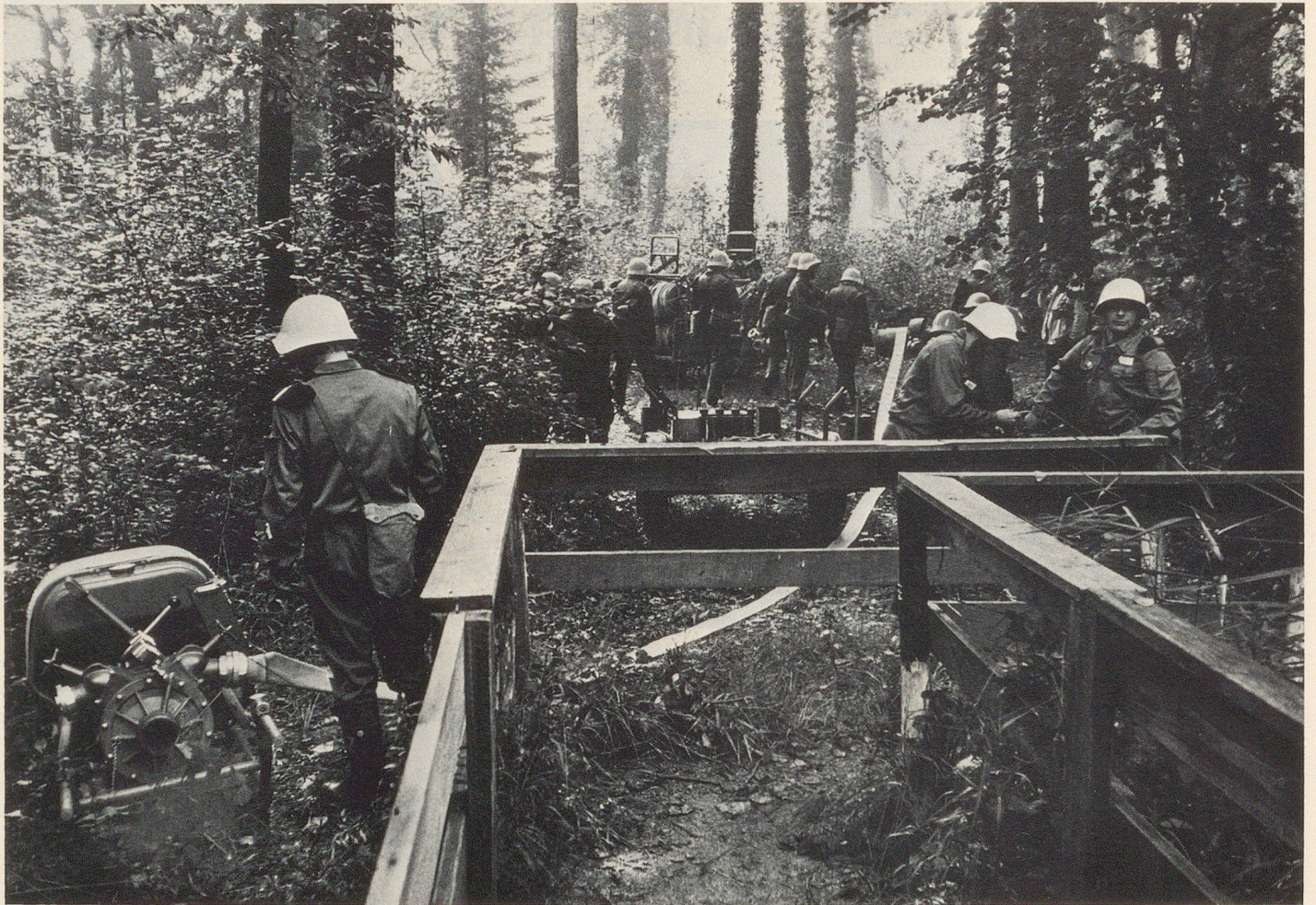
Aufbau des Wassertransportes ab Wasserbezugsort Emmenkanal zum Ausgleichbecken am Rand der Schadenzone.
