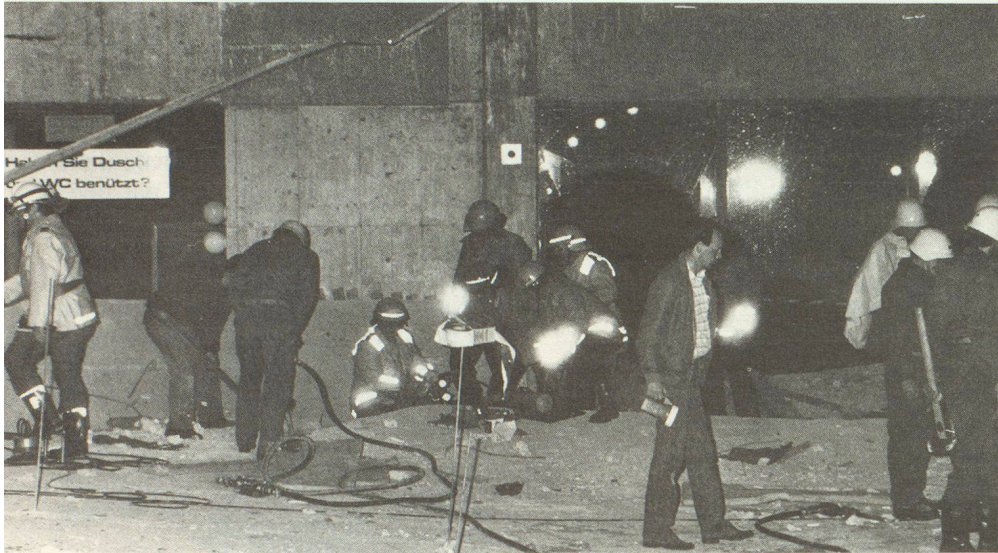
Des membres de la PC s'emploient à percer des trous dans le plafond effondré de la piscine, pour les recherches.
