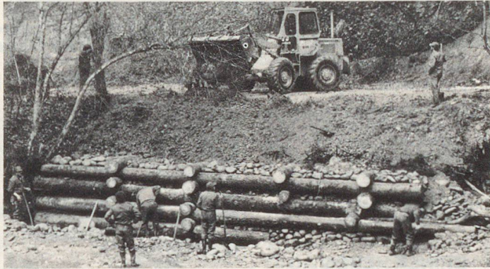
Flussuferverbauung an der Zulgt.
