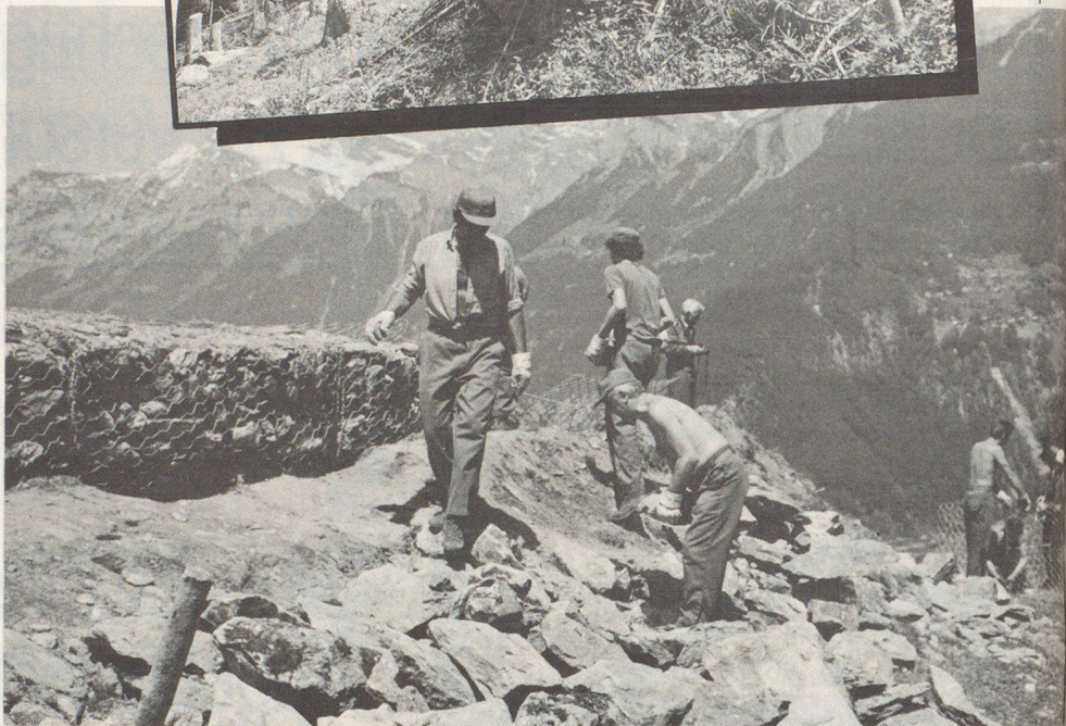
Lawinenverbauung in Amsteg.
