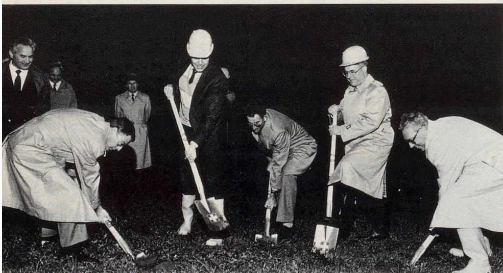
«Gemeinsam anpacken – vom Spatenstich bis zur Eröffnung!» (v.l.n.r.: G. Foppa, Vizepräsident des SRK-Stiftungsrates; J. Hammer, Präsident der Arbeitsgemeinschaft SBG/SRK; H.-P. Kurz, künftiger Zentrumsleiter; E.O. Fischer, Architekt)
