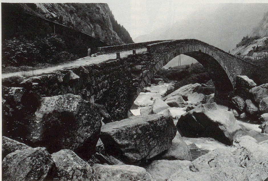
Le vieux pont romain dans la «Schöllenen» (Uri), détruit par les eaux en 1987.
