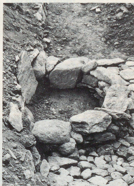
Kunstvoller Filterbrunnen innerhalb der Dammschüttung.
