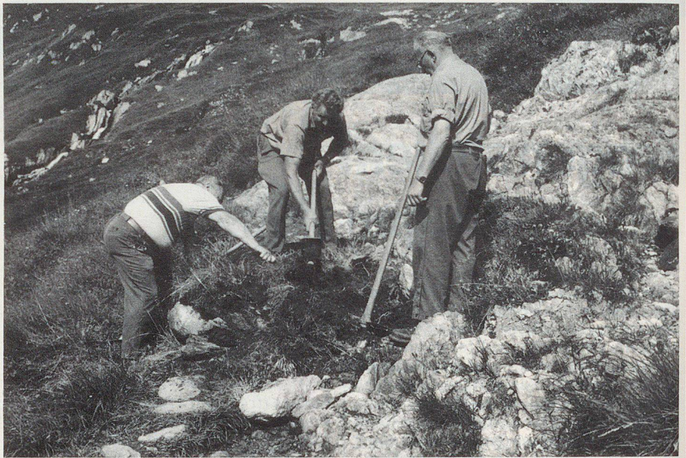
Arbeiten an der Fällilücke.
