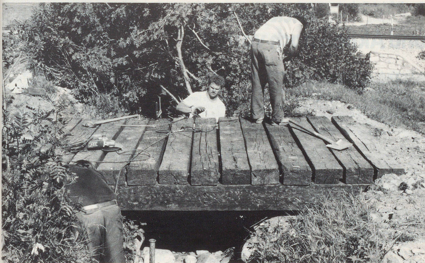
Eine Brücke über einen Seitenbach kurz vor ihrer Fertigstellung.
