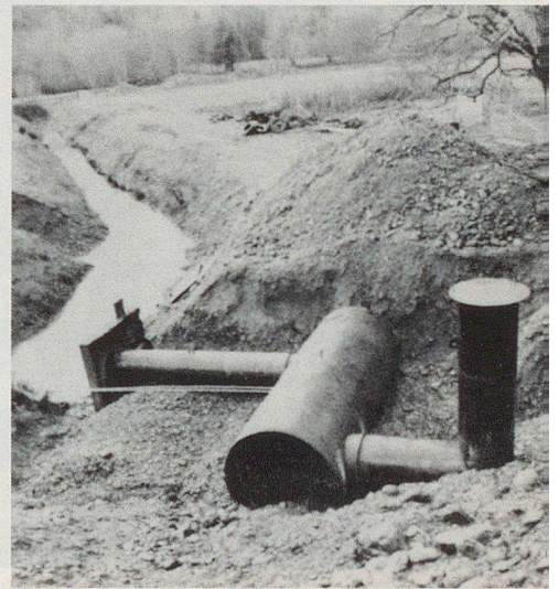
Stahltank-SR in der Baugrube. Links das horizontale Eingangsrohr.
