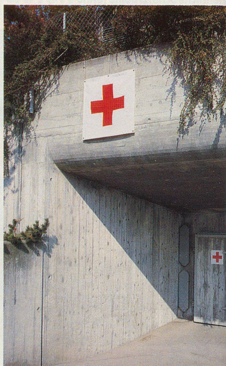
Illustrazione 6 Designazione esterna (esempi possibili) di impianti singoli del servizio sanitario o, in impianti combinati, dell'ingresso separato all'impianto del servizio sanitario, cifra 232, cpv. 4. Segno distintivo della Croce Rossa in materiale tessile, 80x80 cm.
