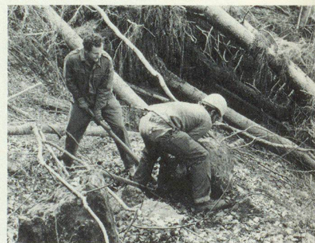
Arbeiten, die vom Zivilschutz ausgeführt werden können: Kleinholz und ausgerissene Wurzelballen beseitigen (Axalp).
