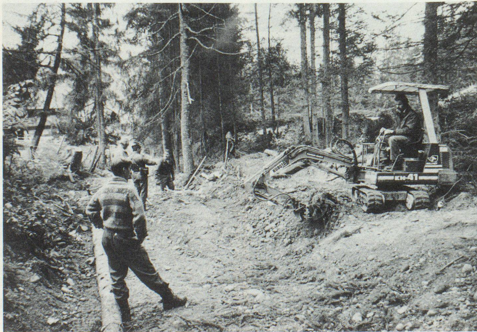
Mit Hilfe von Baggern wird die Böschung ausgehoben.
