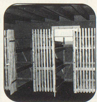
Kellerverschläge aus Schutzraumliegen BK 86
