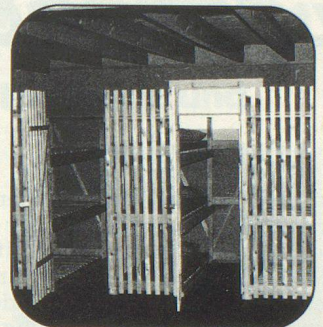
Kellerverschläge aus Schutzraumliegen BK 86
