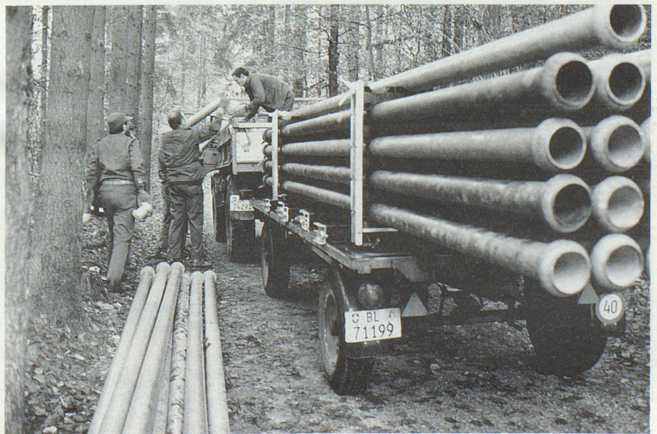
Das Verlegen der 830 Meter langen Wasserleitung vom Allschwilerweiher zum Biotop.
