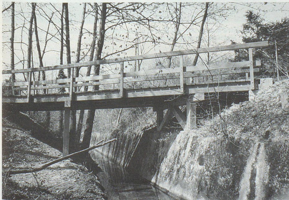
Le pont sur le Lavasson: «De la belle ouvrage» comme on dit dans le canton.
